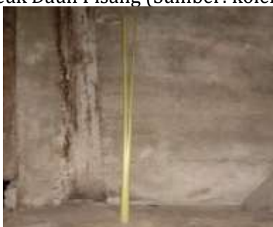
Foto 3. Plutuak (Sumber: koleksi pribadi)
