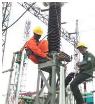
Gambar 5. Pengujian Tahanan Isolasi CT
